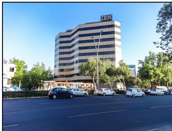
Edificio IBM en Providencia 655
